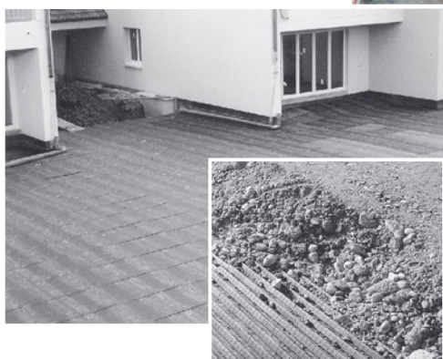
REPLAST «R» mis en œuvre horizontalement comme couche de protection et de drainage
