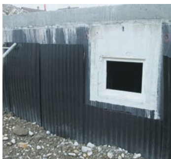
REPLAST «R» mis en œuvre horizontalement comme couche de protection et de drainage
